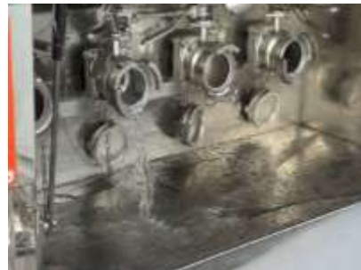
Eliminación del derrame
